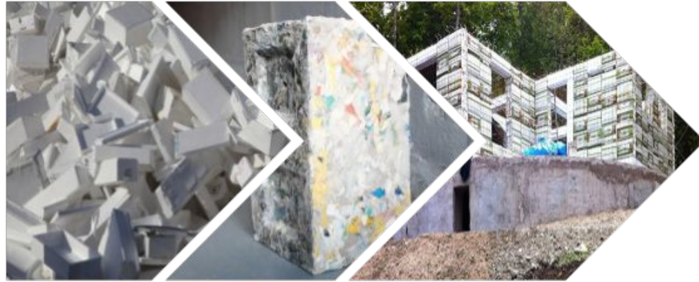
FIGURE 7 Utilisation de styromousse en brique pour la construction, SHE Build 2016
